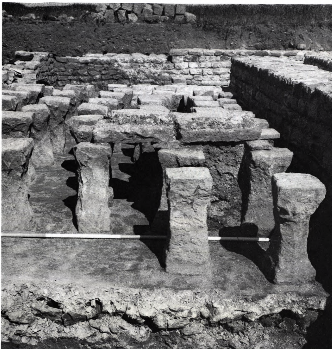
BLICK VON WESTEN IN DAS TEPIDIARIUM DES JÜNGEREN BADES – ERSTE PHASE. Die dicht gereihten Pfeilerchen der Hypokaustheizung sind hier nicht aus hitzebeständigen Ziegelplatten, sondern aus Buntsandstein geschaffen. Sie wurden von der hochtemperierten Heizluft erheblich angegriffen. Die Pfeiler stehen über einem soliden Estrich (im Bild unten). In der Bildmitte über einigen Pfeilern noch Abdeckplatten, über denen der Fußbodenestrich des Tepidariums aufgebracht war.
