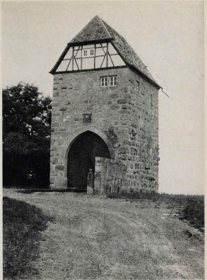
Landturm der Rothenburger Landhege bei Lichtel Süd-(Innen-)Seite nach der Erneuerung
