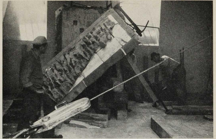
Karlsruhe Schloß Badisches Landesmuseum links oben Einführen eines Blockes in den Aufzugschacht links darunter Transport in den Keller rechts oben Aufstellen eines Blocks rechts darunter Abnahme einer Schutzplatte
