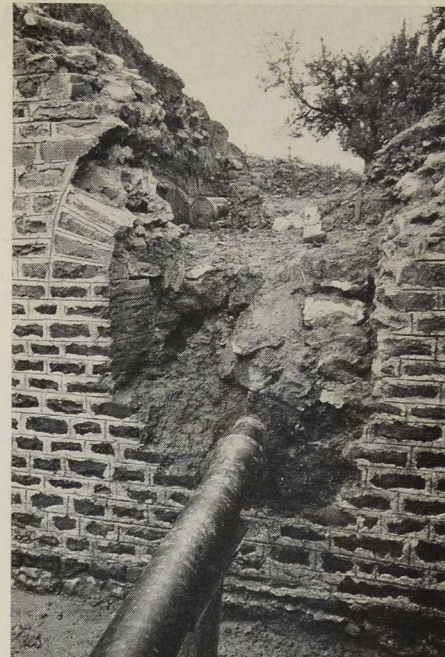
Wössingen (Ldkrs. Karlsruhe) Römischer Keller links Westwand bei der Entdeckung rechts Beschädigung durch Wasserleitung Alle Aufnahmen dieses Aufsatzes Bildarchiv StAfD Karlsruhe
