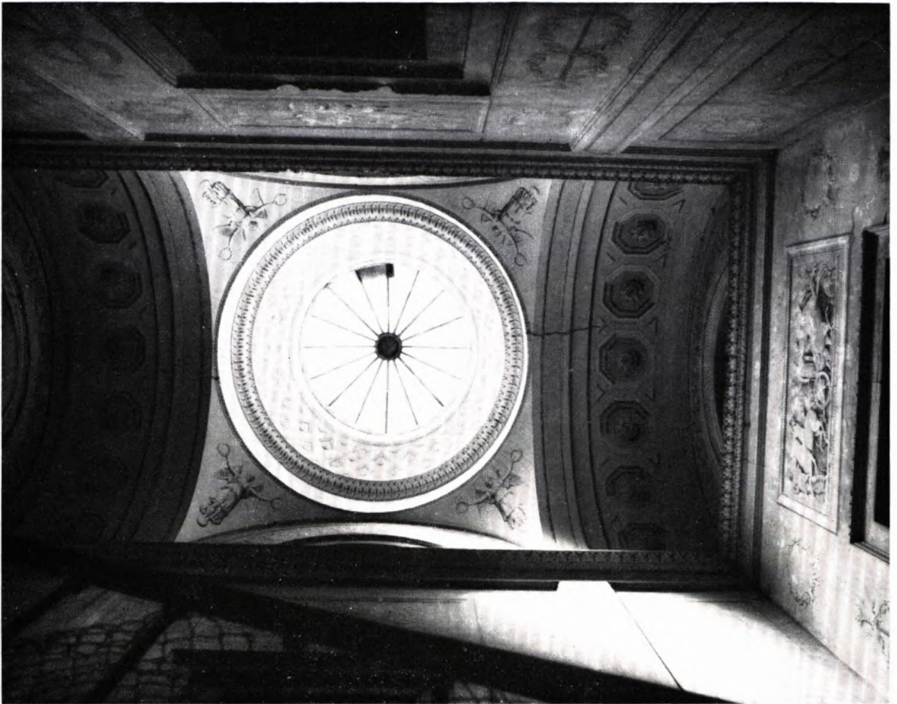
BLICK IN DIE LICHTKUPPEL ÜBER DEM TREPPENHAUS VON SCHLOSS WEIL. Die Idee, ein gefangenes, also von Räumen ringsum eingeschlossenes und nur von oben her belichtbares Treppenhaus zu schaffen, ist kühn. Fast revolutionär aber mußte es zur damaligen Zeit sein, den zeltartigen Verschuß über dem Kuppelauge als Glas-Eisen-Konstruktion zu geben. Großartig wie das architektonische Konzept die gemalte Ausstattung des Treppenhauses. Auf Ocker-Braun-Töne beschränkt, ist sie mit solchem Raffinement geschaffen, daß es schwierig wird, gemalte und plastische Teile voneinander zu trennen (vgl. Abb. S. 31).
