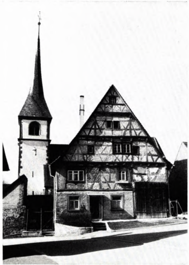
Blick von Süden auf Kirche, Beinhaus (links) und 1970 abgebranntes Fachwerkhaus.
