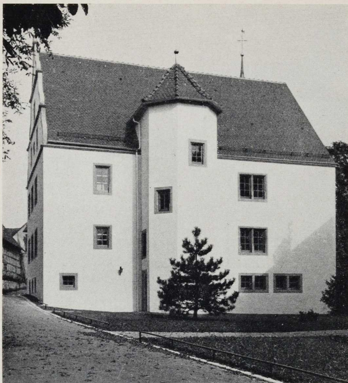
Südseite mit Treppenturm nach der Instandsetzung
