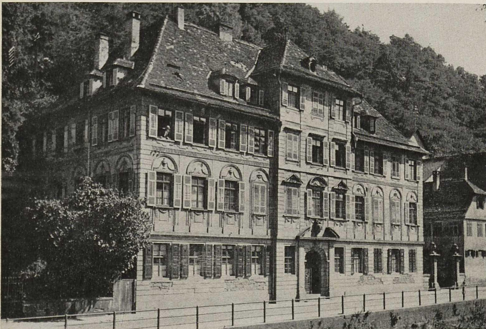
Calw. Haus Vischer (Schütz) Bischofstraße 48 (früher Calw No. 493) vor der Restaurierung
