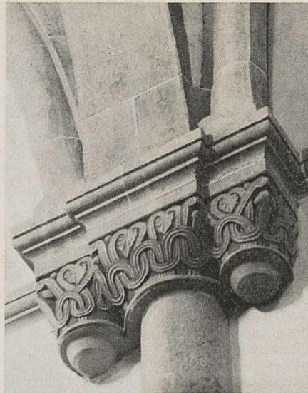
Wölchingen. Evang. Kirche. Langhaus. Hochschiff. Am Obergaden Auflager der Gurtbogen und Rippen
