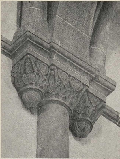
Nordseite. Mittlerer Gurtbogen
