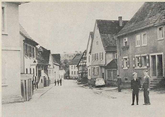
Rinklingen. Breiten Weg
