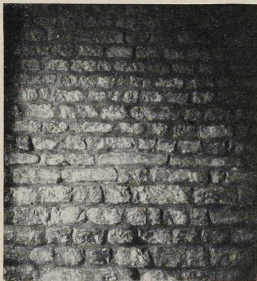
Ottmarsheim (Oberelsaß) Turmvorhalle
