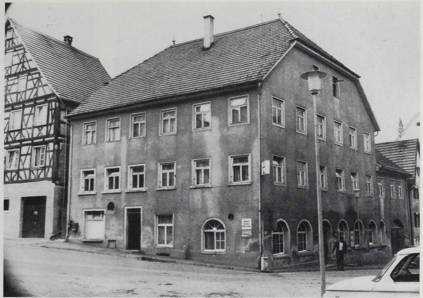
10 GASTHAUS „OCHSEN“. Die Aufnahme von 1976 zeigt den Bau vor der Renovierung.
