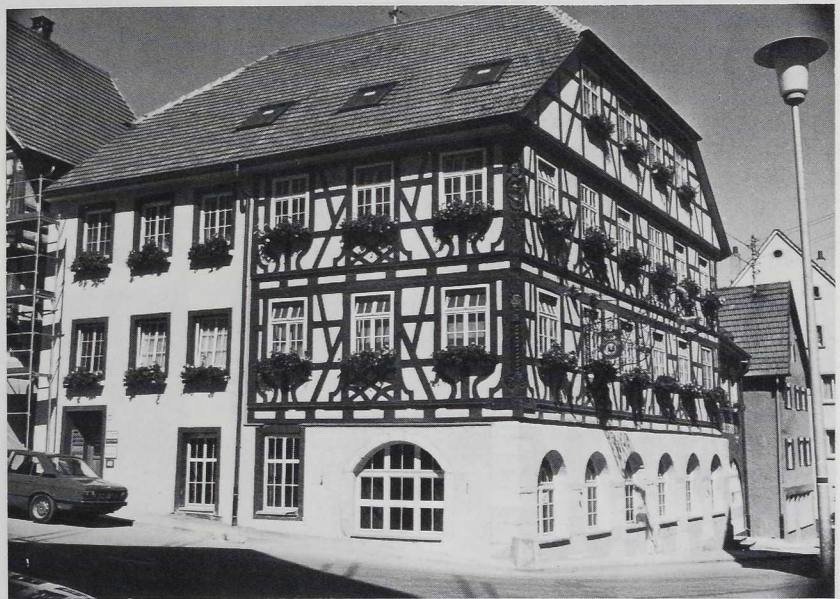
11 GASTHAUS „OCHSEN“. Nach der Fachwerkfreilegung kam reiches Fachwerk mit geschnitzten Eckständern zum Vorschein.
