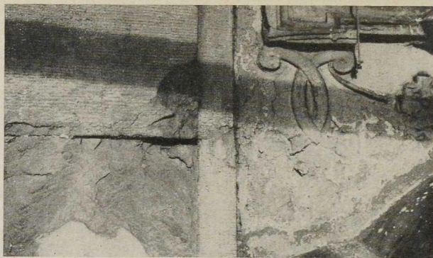
Schwäbisch Hall. Haus am Marktplatz 10 (Finckh'sches Haus). Zerfallerscheinungen vor der Instandsetzung an der Büste Kaiser Constantins an Pilaster und Bandelwerk in Putz an Pilasterkapitell
