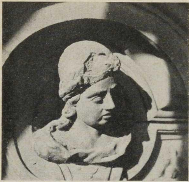
Schwäbisch Hall. Haus am Marktplatz 10 (Finckh'sches Haus). Zerfallerscheinungen vor der Instandsetzung an der Büste Kaiser Constantins an Pilaster und Bandelwerk in Putz an Pilasterkapitell
