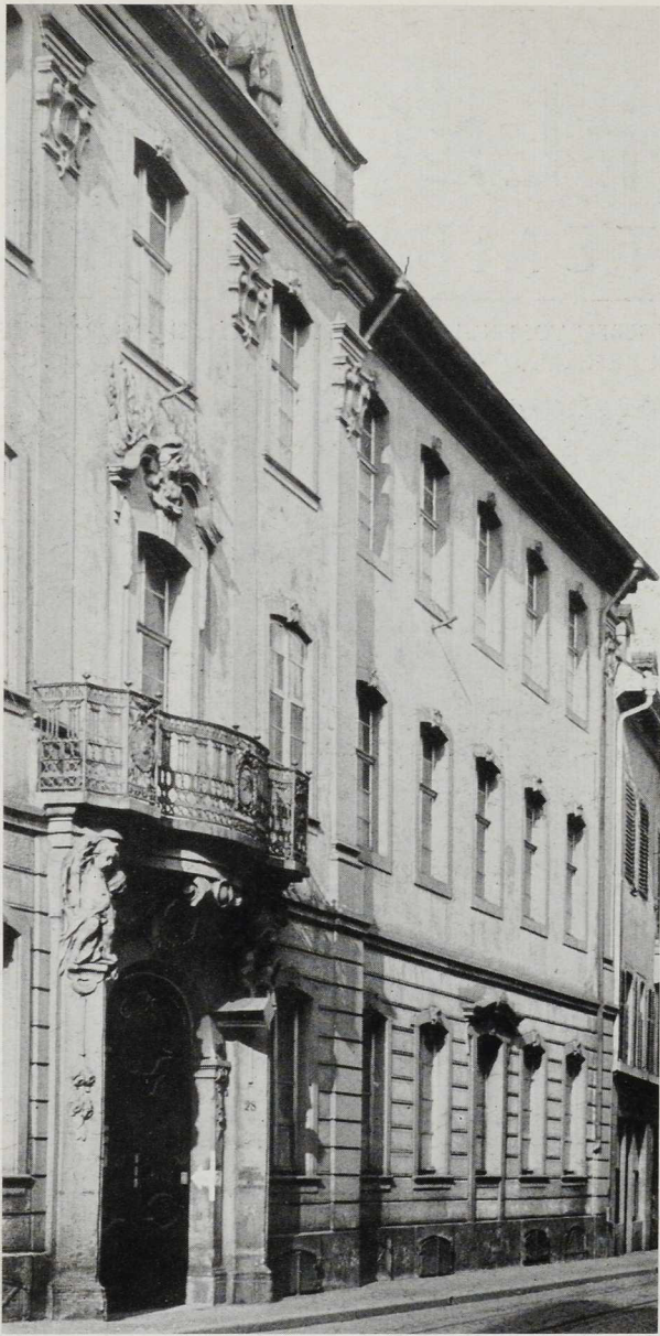
Die Deutschordenskommande Freiburg i. Br. Mittelrisalit mit Portal und Balkon und westlicher Seitenteil vor der Zerstörung von 1944 Aufn. Planungsamt der Stadt Freiburg i. Br. (Ruth Fabel-Albenhausen)
