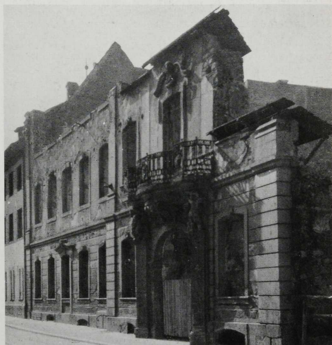
Ruine der Deutschordenskommande Mittelrisalit und östlicher Seitenteil nach der Zerstörung von 1944
