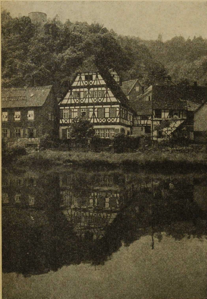
Gernsbach im Murgtal Die frühere Kellerei des Domstifts Speyer
