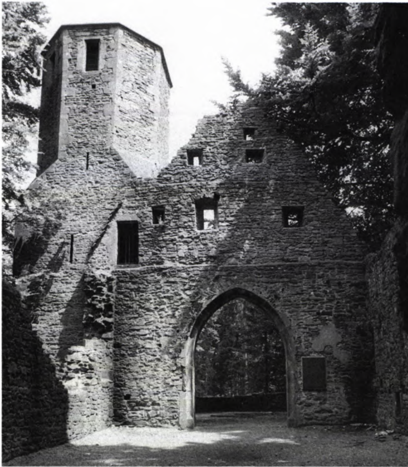
12 EHEM. BARBARAKAPELLE bei Langensteinbach, Gde. Karlsbad, Kr. Karlsruhe, als Beispiel einer den Ruinencharakter berücksichtigenden Sicherung, Zustand 1971.
