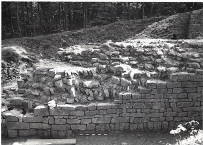
6 LANGENSTEINBACH, Gemeinde Karlsbad, Kr. Karlsruhe; sorgfältig gerichtete Außenschalen mit Zwischenfüllung im Fischgrätenverband.
