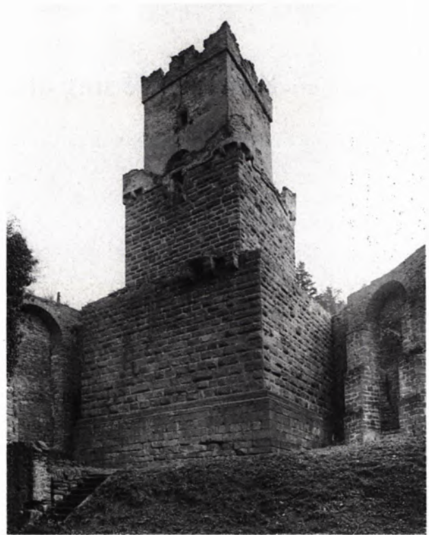
16 FREUDENBERG, Aufnahme von 1984. Der Turm und das Gelände sind vom Bewuchs befreit. Es zeigt sich, daß die ersten beiden, Ende des 12. Jahrhunderts erbauten Stockwerke des Turmes noch recht gut erhalten sind. Lediglich der Ende des 15. Jahrhunderts errichtete Aufsatz weist Mauerausbrüche und einen klaffenden Riß an der Nordseite auf.
