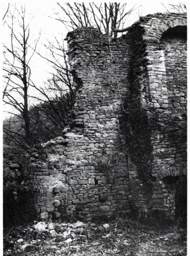
14 FREUDENBERG, Aufnahme im Frühjahr 1984. Die Treppenturmreste sind abgebrochen. Das Photo von 1983 besitzt bereits nach einem Jahr dokumentarischen Wert.
