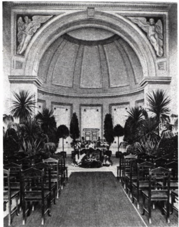
6 DIE AUFBAHRUNGSHALLE des Krematoriums um 1901.
