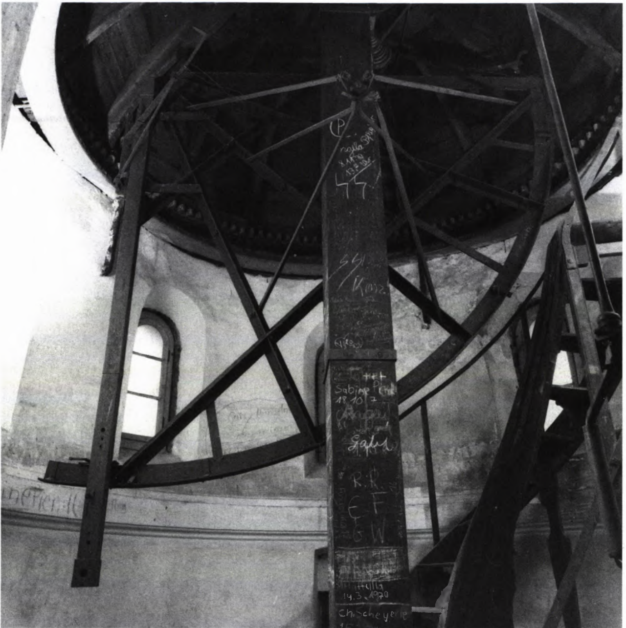
3 DER GROSSE AZIMUTALQUADRANT in der drehbaren Sternwarkuppel. Deutlich erkennt man den Zahnkranz der Kuppel und die ebenfalls drehbare Wendeltreppe. Der Quadrant ist an der schwarzen Säule befestigt, welche drehbar gelagert ist. Die Aufnahme wurde im Dezember 1982 gemacht, nachdem die Originalbespannung der Kuppel bereits vorsichtig abgenommen wurde. Am Quadranten fehlen alle Messingteile, Justiervorrichtungen und die Optik.
