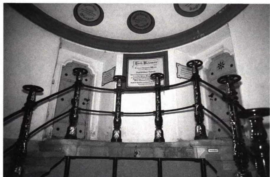
8 TREPPENANLAGE mit Drehschiebern. Im Hintergrund die Eingänge zu den beiden Wasserkammern.
