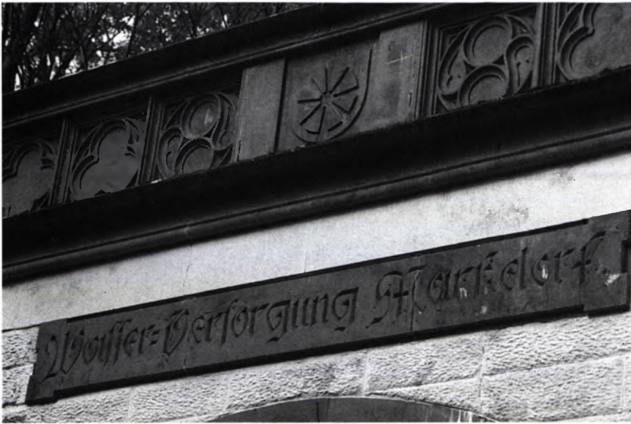
4 MARKDORF, Detailansicht der Brüstung mit Wappen der Stadt.
