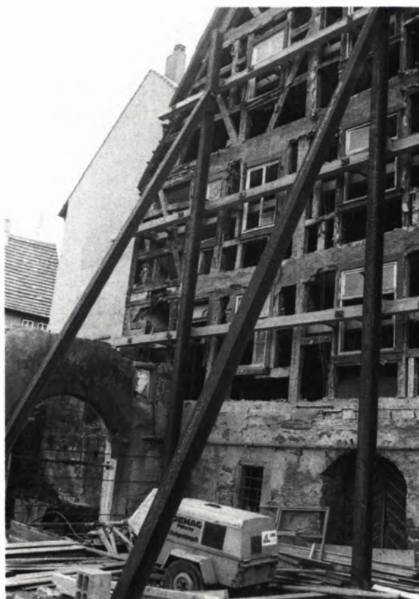
4 GASTHAUS „ZUM RIESEN“ während der Sanierung, 1984.
