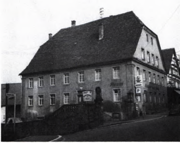
3 GASTHAUS „ZUM RIESEN“ in Walldürn, Hauptstraße 14, Zustand 1974.
