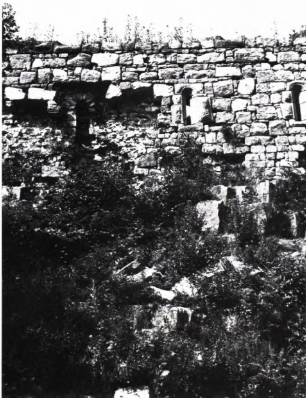
1 KIRNBURG, PALAS-WESTWAND mit teilweise bossiertem Mauerwerk.
