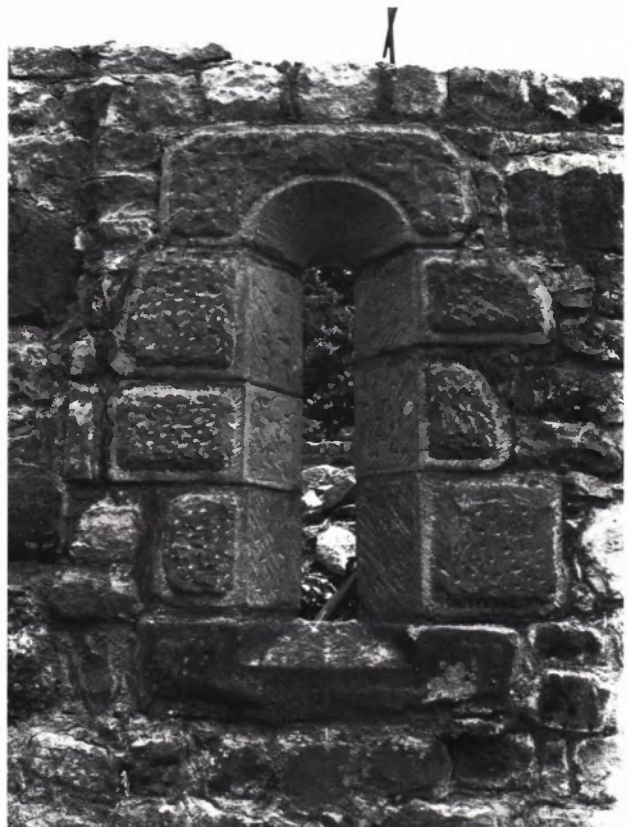
5 DIE NORDWAND nach der Sanierung mit erneuertem Fenstergewände.
