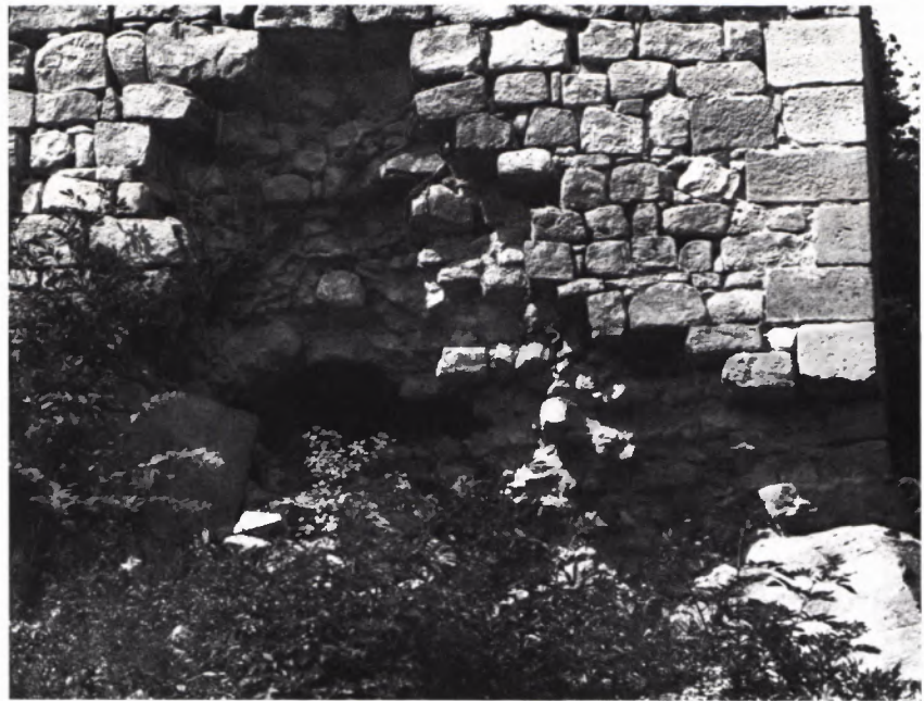
3 DURCHBRUCH an der Palas-Nordwand durch die 2 Meter dicke Wand unter dem Rundbogenfenster.
