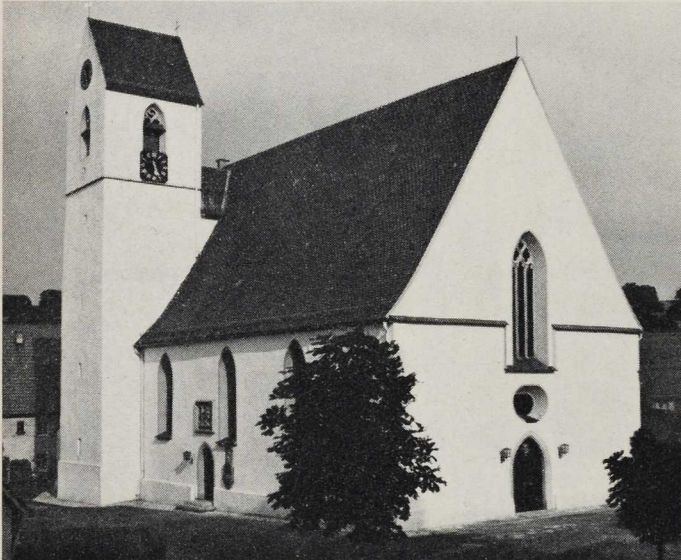
Trochtelfingen. Kath. Stadtpfarrkirche von Nordwesten
