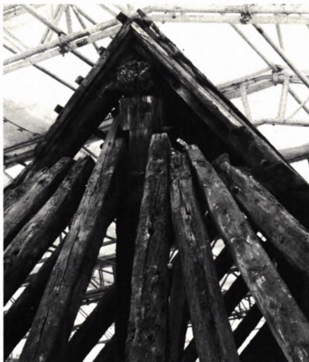
8 DAS „RAUCHLOCH“ ÜBER DEM HALBWALM. DER 4. SPARRN (VON LINKS) LÄUFT BIS ZUR FIRSPFETTE DURCH UND IST AN DIESER SOWIE AN DER FIRSÄULE ANGEBLATTET.
