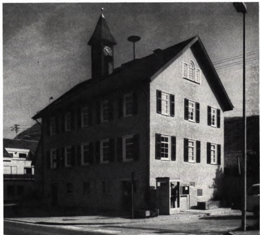
7 BRÜCKEN. Das ehem. Schulhaus ist ein verputztes Fachwerkgebäude aus der Mitte des 19. Jh. Nach einer Beratung durch die Denkmalpflege verzichtete der Gemeinderat 1981 auf die Freilegung. Die gegliederten Fenster sind durch die Fensterläden in die gespannte Putzfläche eingebunden. Die Gestaltung der Fenstergruppe in der Giebelspitze mit der halbkreisförmigen Mittelöffnung verlangt zwingend die anschließende Putzfläche.
