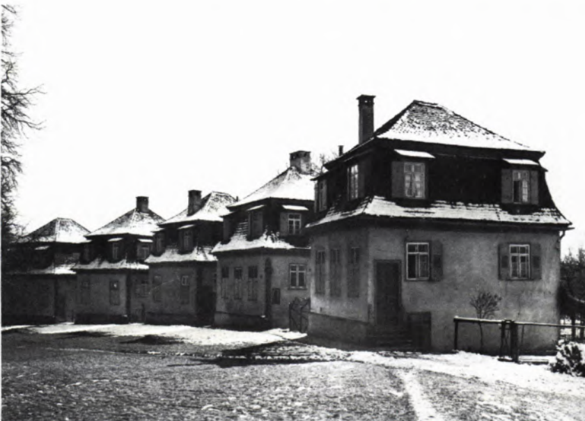
3 STUTTGART. Die Kavaliershäuschen beim Schloß Solitude (Zustand 1930) sind ein Beispiel für die Nachahmung von Steinbauten in der 2. Hälfte des 18. Jh. Die Fachbauweise ist nur an Details – Halffutter und Bekleidung aus Holz – oder an Putzrissen zu erkennen. Niemand denkt hier an Fachwerkfremdung, allenfalls bei schadhafter Fachwerkssubstanz an den Ersatz durch „echte“ Steinbauten in derselben Form.
