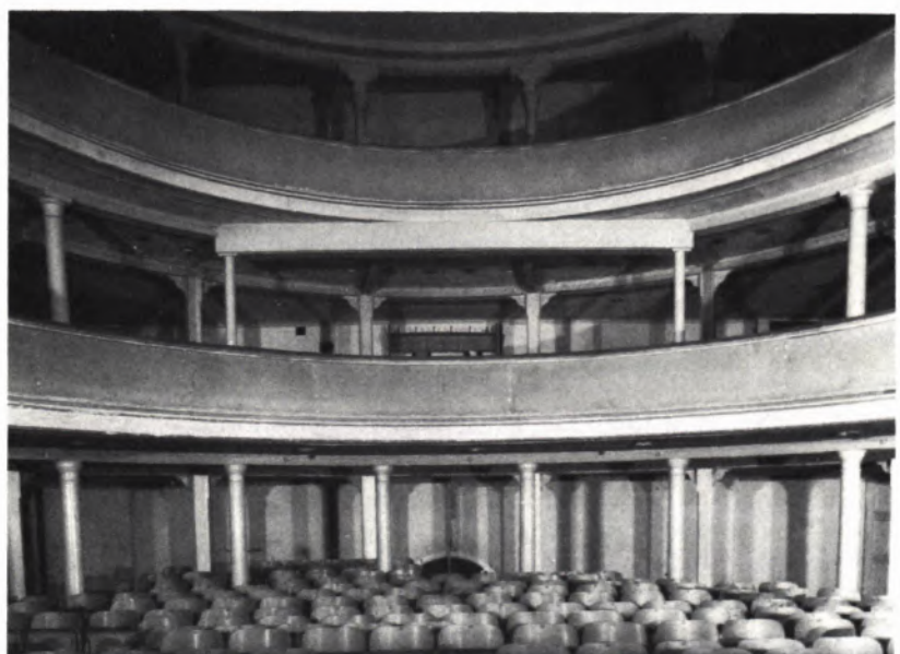
5 DER ZUSCHAUERRAUM des Wilhelmatheaters 1982. Auf kreisförmigem Grundriß umschließen zwei Ränge den Zuschauerraum. Der als Notkonstruktion eingefügte Unterzug stört.
