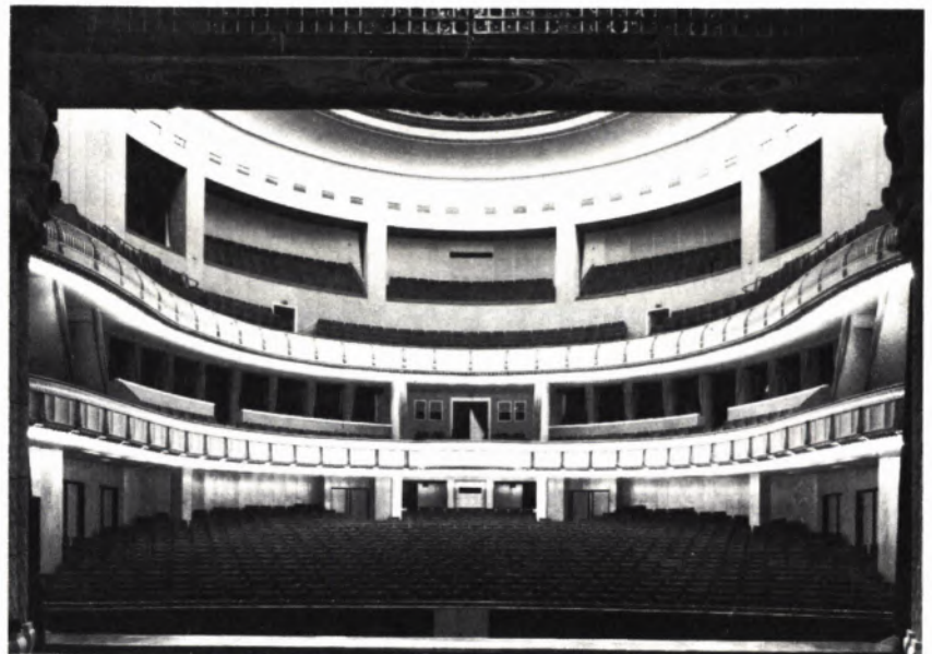
8 GROSSES HAUS, Aufnahme von 1961 nach dem Umbau: Gebremster Stuck, Glattflächigkeit, gestraffte Konturen durch neue Beleuchtung verstärkt ersetzen Littmanns Konzeption.
