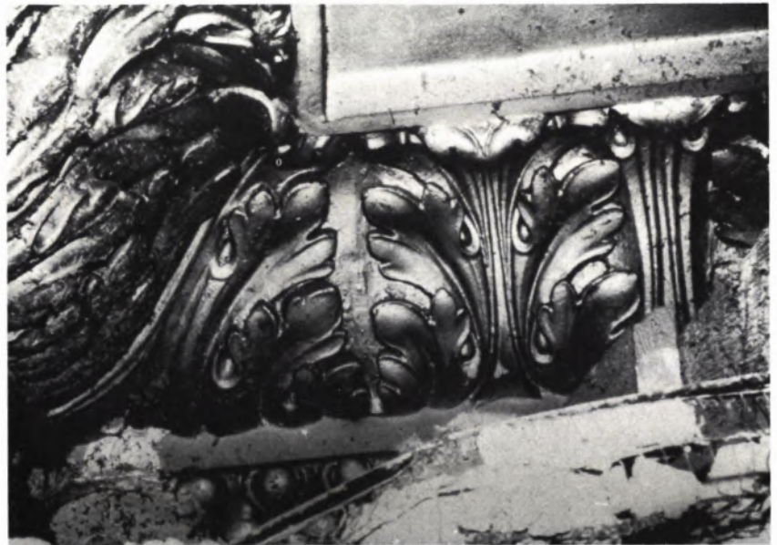
12 DECKENAUSSCHNITT im Zuschauerraum. Der Blick in eine der 1982 probeweise geöffneten, 1956 verschalteten Kassetten der Decke zeigt die noch erhaltenen Stukkaturen.
