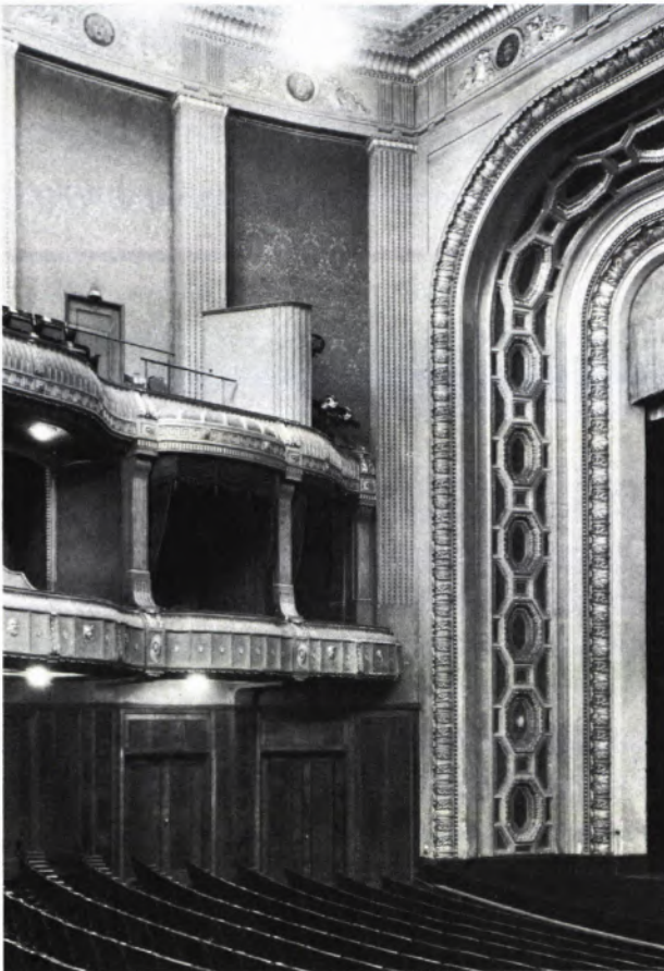
10 GROSSES HAUS, Proszeniumsbereich im alten Zustand 1956 aufgenommen. Der schwer kassettierte Bühnenrahmen und die Stukkaturen an Wänden und Decke streuten den Klang besser als die späteren glatten Wand- und Deckenflächen.
