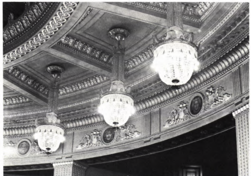
13 DECKENAUSSCHNITT aufgenommen 1956, Zustand vor dem Umbau, der 1983/84 wiederhergestellt wird.
