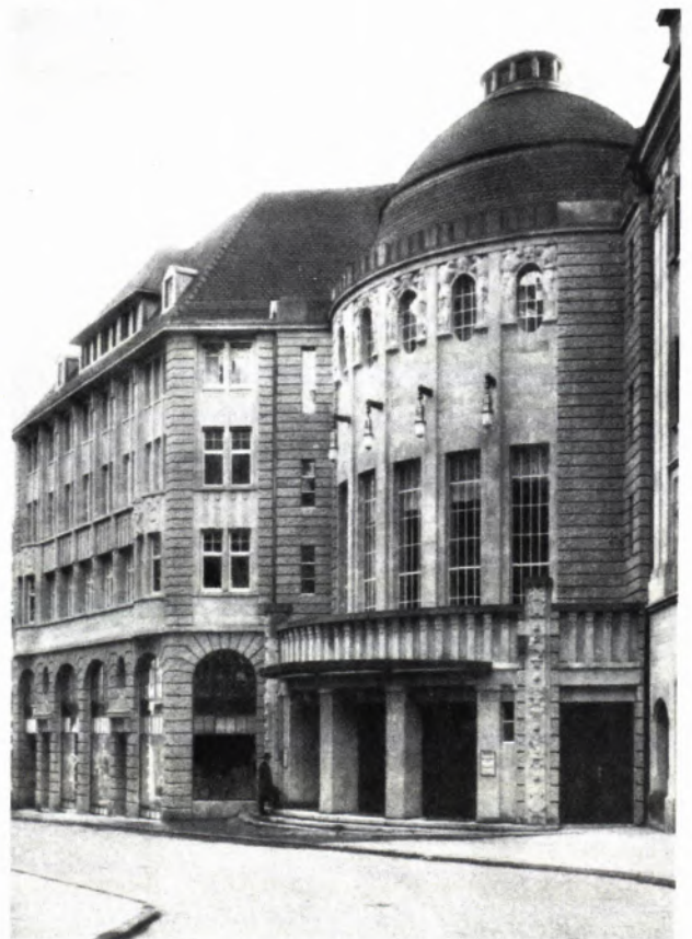
14 DAS SCHAUSPIELHAUS in Stuttgart kurz nach seiner Fertigstellung.
