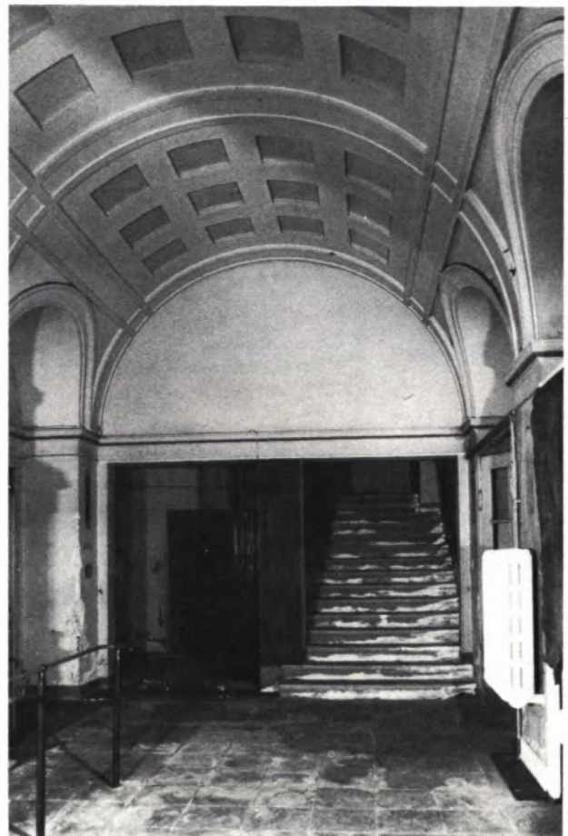
4 DIE EINGANGSHALLE des Wilhelmatheaters 1982. Die wesentlichen Architekturelemente sind noch vorhanden.
