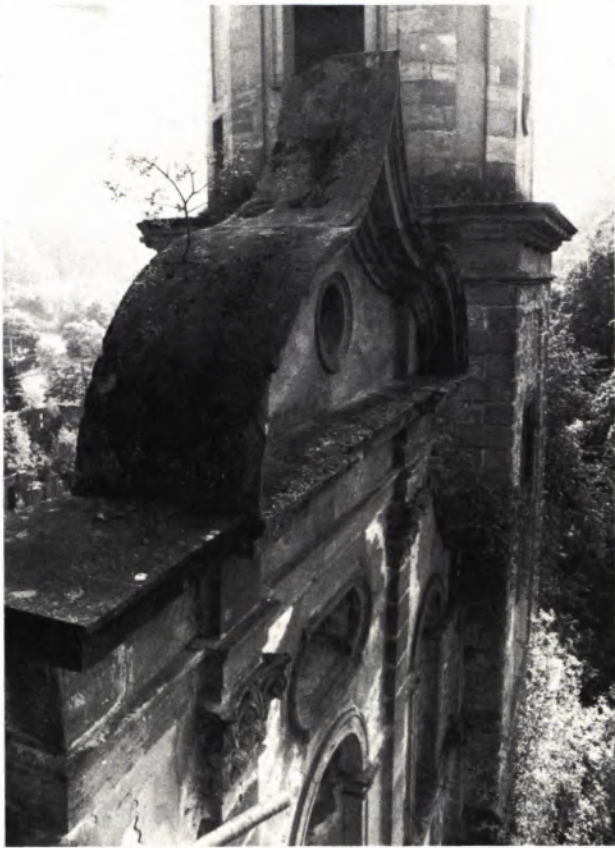
7 GIEBEL, Frontseite vor der Sanierung.
