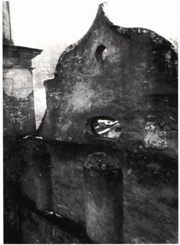
8 GIEBEL, Innenseite vor der Sanierung.
