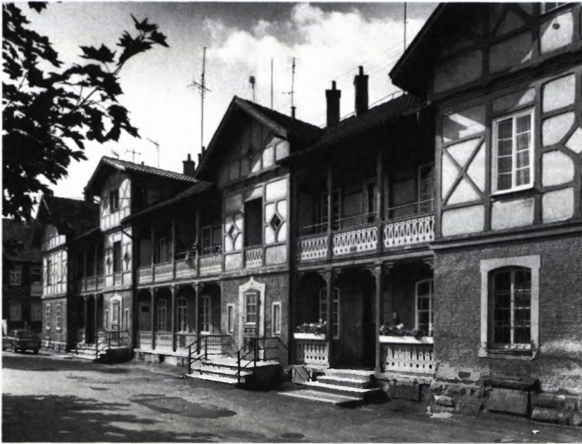
7 MEHRZWECKGEBÄUDE (Bleicherstraße 19), 1864 errichtet, wegen der mit Sägeornamentik geschmückten und durch hölzerne Kapitellstützen gegliederten Lauben im Volksmund „Texasranch“ genannt. Der Mittelbau enthielt im Erdgeschoß Wohnungen für Aufseher und Lehrer, im Obergeschoß Schullokal, Bibliothek und Lesezimmer, Apotheke und das Spital, dessen Räume als Kindergarten bzw. Versammlungs- und Unterhaltungsort für erwachsene Mädchen verwendet wurden. In den beiden Flügeln befanden sich Arbeiterwohnungen und der als Kaufladen benutzte Kindergarten.
