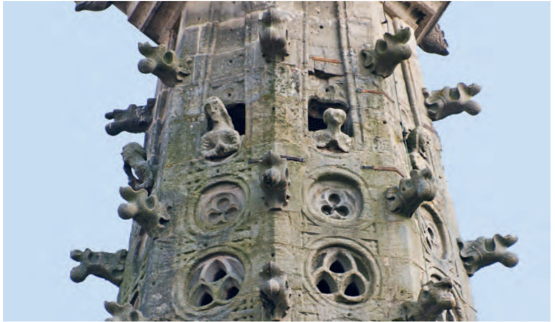
4 Ansicht der Büstengruppe unterhalb des oberen Turmumgangs von Nordwesten.
