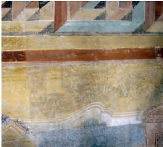
5 Arbeitsprobe im Jahr 2003 zur Abnahme des Schimmelpilzbefalls auf der Nordwand.
