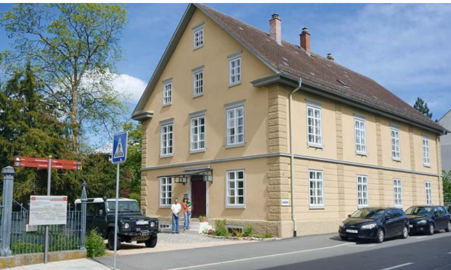
12 Das ehemalige Beamtenwohnhaus nach der Instandsetzung, authentisch bis ins Detail mit einem zukunftsfähigem Nutzungskonzept: repräsentative Räume im Erdgeschoss für eine Kanzlei und eine großzügige Wohnung im Obergeschoss. Vor dem Eingang: Preisträgerfamilie Förster.
