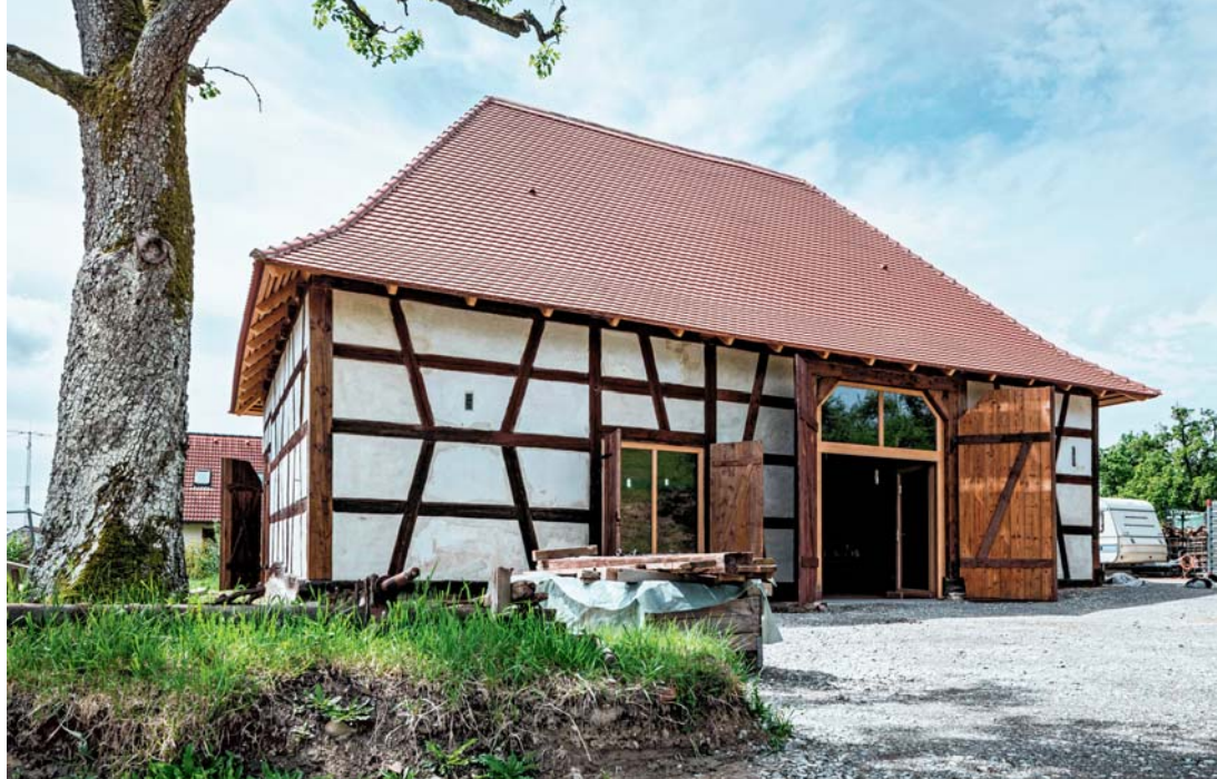
4 Das Tennentor war im späten 19. Jahrhundert nicht fachgerecht eingebaut worden und musste aus statischen Gründen etwas verkleinert und ertüchtigt werden. Im Zuge der Renovierungsmaßnahmen wurde das kleine Tor daneben zur Belichtung der Halle reaktiviert.
