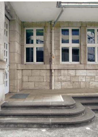
9 Öffentlicher Eingang zum Obergeschoss, Gebäuderückseite.
