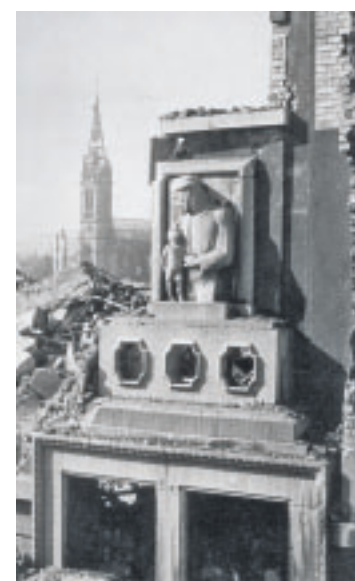
5 Aufnahme der Trümmer des im Zweiten Weltkrieg zerstörten Lutherhauses im Jahr 1948.
