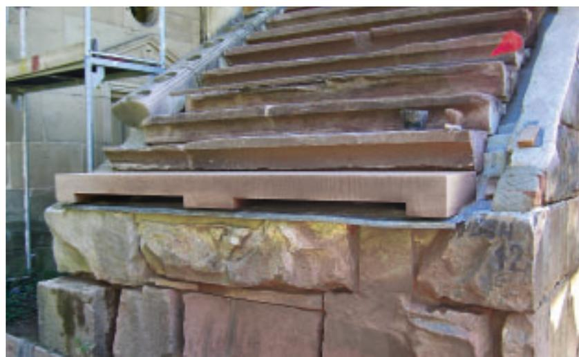
10–11 Treppe während der Versetzarbeiten mit quer verlaufenden Auflagern und mit der neu gearbeiteten Abschlussstufe 2010/2011.
