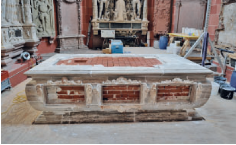
8 Die gräfliche Tumba in Wertheim mit neu gemauertem Ziegelkern beim Wiederaufbau, August 2014.
