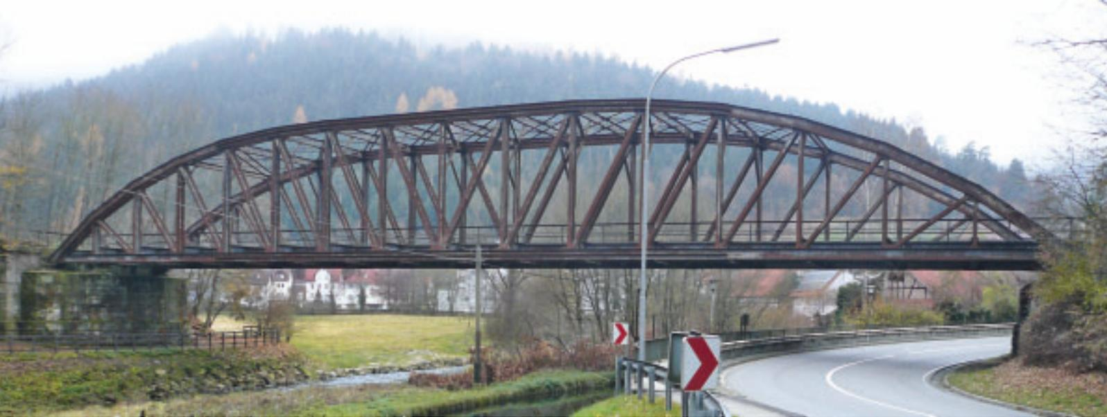
In den 1860er und 1870er Jahren wurden Schwedler-Träger für Brücken mit Stützweiten zwischen 30 und 70 m sehr häufig eingesetzt, so auch auf der Strecke zwischen Pforzheim und Horb. Bis zu ihrer Zerstörung im Zweiten Weltkrieg überspannten zum Beispiel mehrere Brücken dieses Typs neben- und hintereinander den Neckar bei Horb. Die Brücke in Unterreichenbach blieb von Zerstörung verschont und wird bis heute täglich von der Nagoldbahn befahren, die heute als Kulturbahn bekannt ist (Abb. 3).
