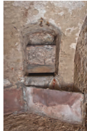
7 Raum R-2.11 mit Wasserbecken im Untergeschoss des Gasthauses.
