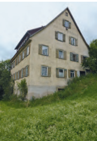
9 Gasthaus zum St. Jakobsbad, Zustand 2012.
