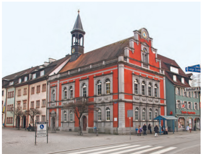
1 Das aus mehreren Bauteilen zusammengesetzte Rathaus der Stadt Waldkirch: vorne das Alte Rathaus mit reich gegliederter Fassadengestaltung von 1871 und großem Ratssaal, dahinter der Bau der ehemaligen Stadtschreiberei.
