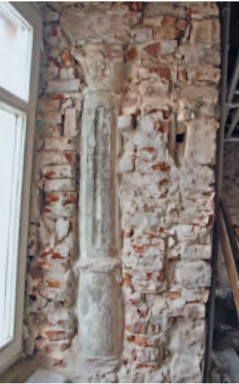
7 Stadtschreiberei, eingemauerte Fenstersäule in der Wand zum Marktplatz im Erdgeschoss, um 1661.
