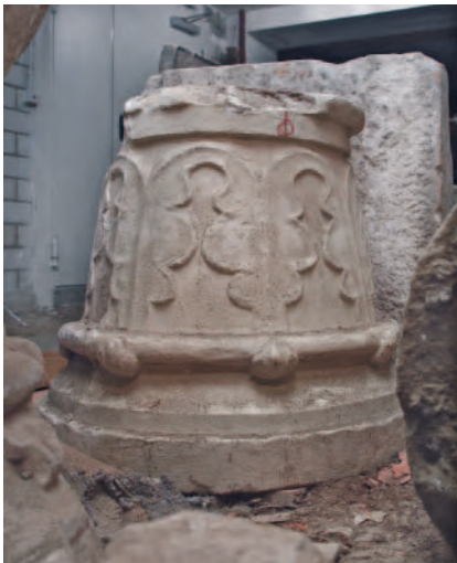
8 Zwei Kapitelle beziehungsweise Kapitell und Sockelstück einer früheren Stütze im Erdgeschoss, die vermutlich aus dem 1530 errichteten Propsteigebäude herrühren.
