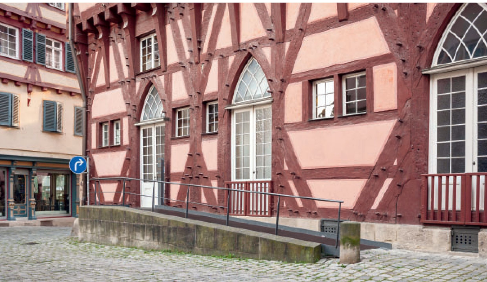
6 Ein positives Beispiel für eine tatsächlich barrierefreie Rampe findet man in Esslingen. Ausgestattet mit Anprallschutz und Handlauf, erschließt sie barrierefrei das Alte Rathaus und hält dabei das vorgeschriebene maximale Gefälle von sechs Prozent ein.
