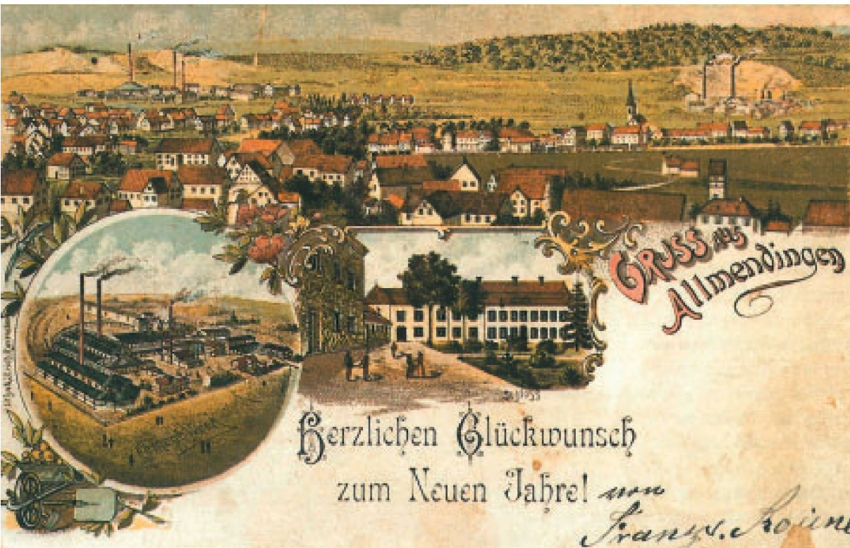
4 Postkarte von Allmendingen mit den beiden Zementwerken von Schwenk (links) und des Stuttgarter Immobilien- und Baugeschäfts (rechts), etwa 1900.
