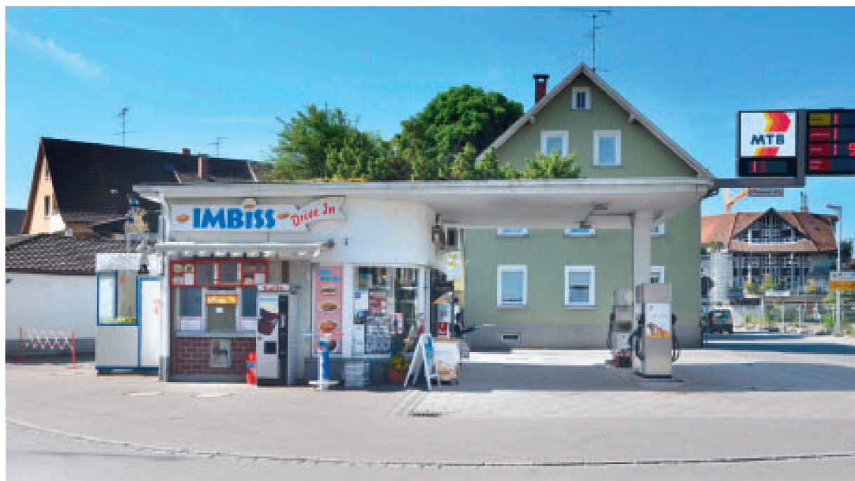
3 Die Tankstelle an der Ravensburger Straße in Tettngang 2013. Für die Bedienung der Imbisskunden war die ursprünglich schmale Außentür in der nördlichen Fassade 1988 zu einem großen Fenster ausgebaut worden.
