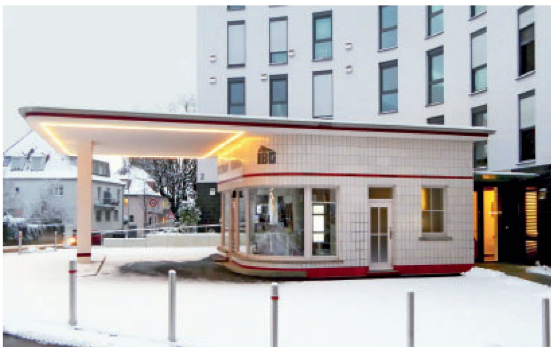
7 Das abgerundete Fensterband der Nordfassade zum Zeitpunkt der Bestandsaufnahme 2013. Hier gut zu erkennen das Prinzip der durchgehenden Fensterbank.
