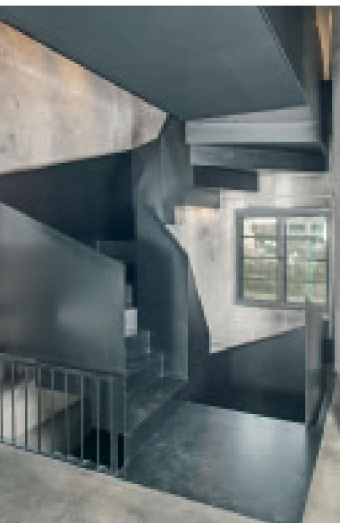
11 Die Etagen unter dem Wassertank werden durch eine neue Treppenanlage erschlossen.
