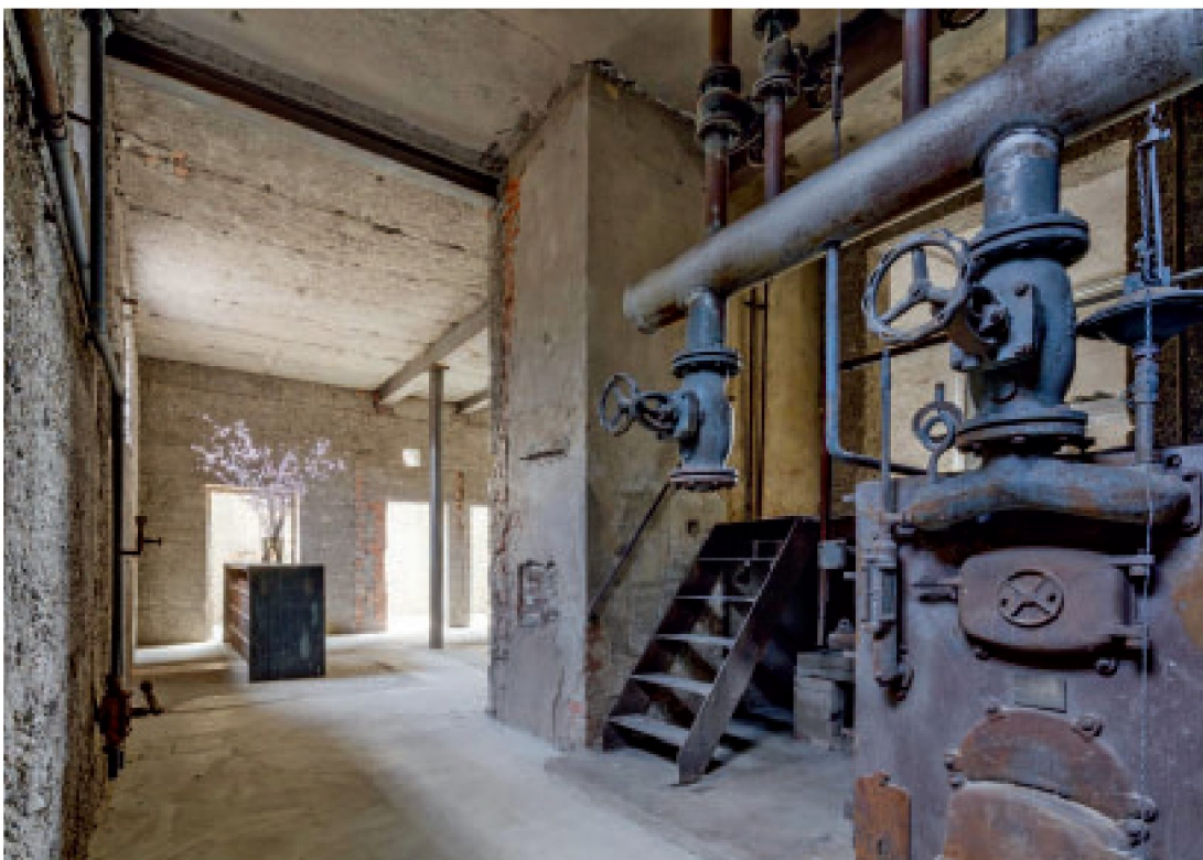
4 Blick ins Kellergeschoss mit seinen alten Leitungen.
