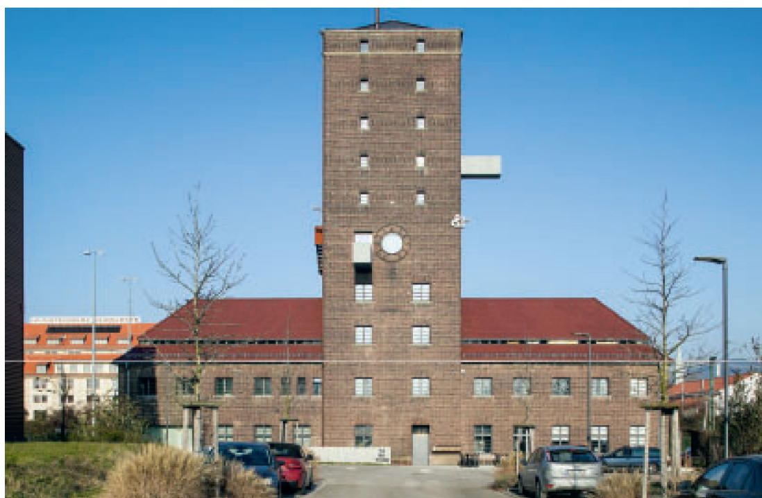
1 Der Wasserturm nach der Sanierung von der Eppelheimer Straße aus.
