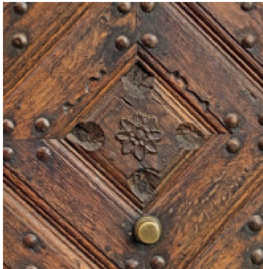
3 Detail der zweiflügligen Hauseingangstür nach der Instandsetzung.
