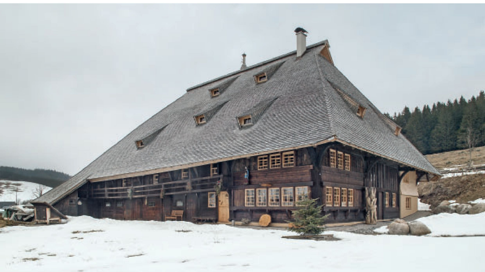
1 Ansicht von Südosten nach der Instandsetzung 2016.
