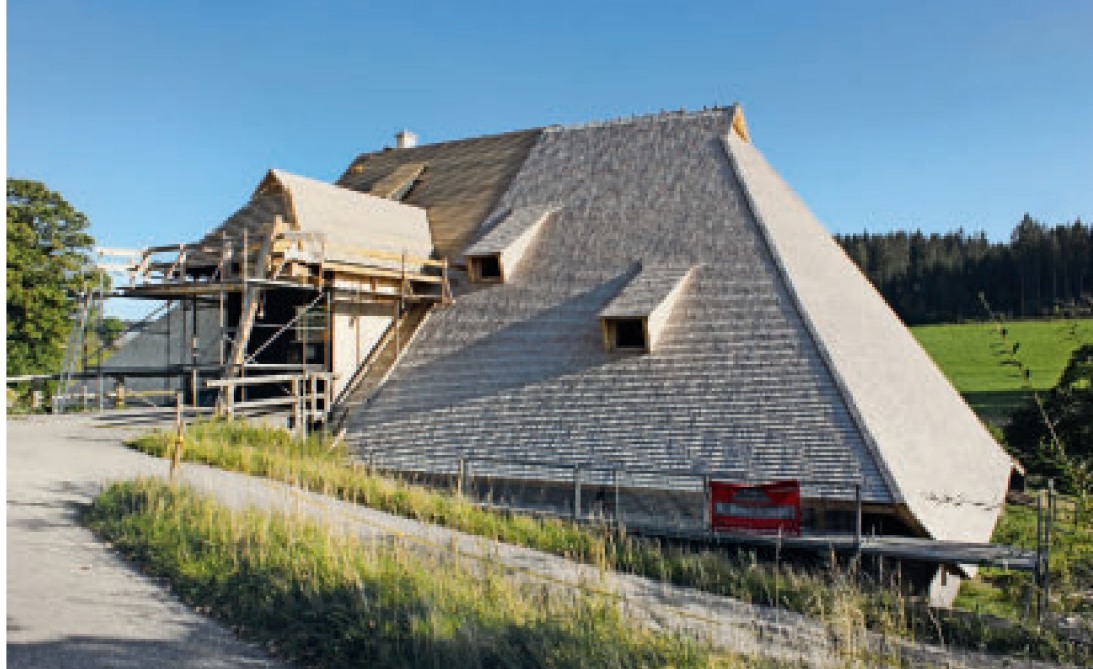
12 Holzschindel als neue Dachdeckung, während der Baumaßnahme von Norden 2014.
