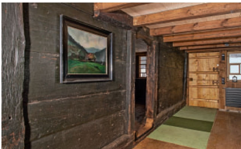
5 Hausgang im Erdgeschoss, bauzeitliche Bohlenwand der Stube.
