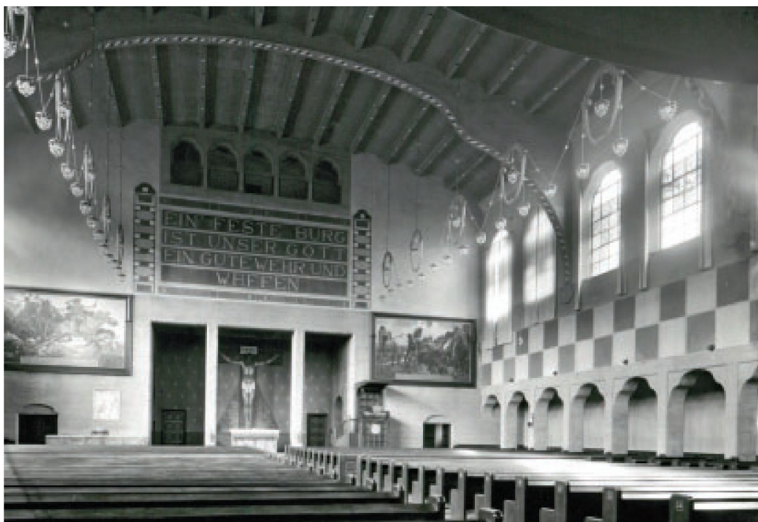
Innenansicht der Pauluskirche in Ulm nach 1910 mit bauzeitlichem Raumkonzept (vor 1970).
