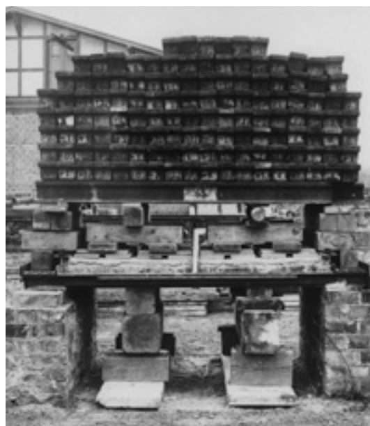
6 Belastungsprobe einer Decke.
