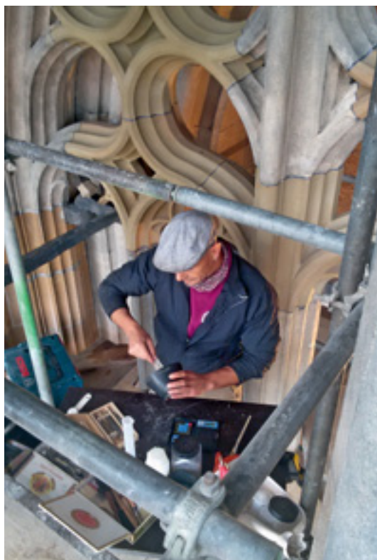
5 Ein Mitarbeiter der Münsterbauhütte bei der Arbeit am Sandstein in 50 m Höhe am Ulmer Münster.
