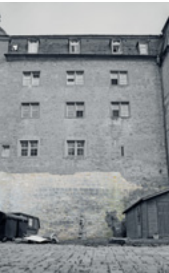
8 Außenfassade des westlichen Galerieflügels mit mittelalterlichem Quaderverband des ehemaligen Burgzwingers im Fundamentbereich.
