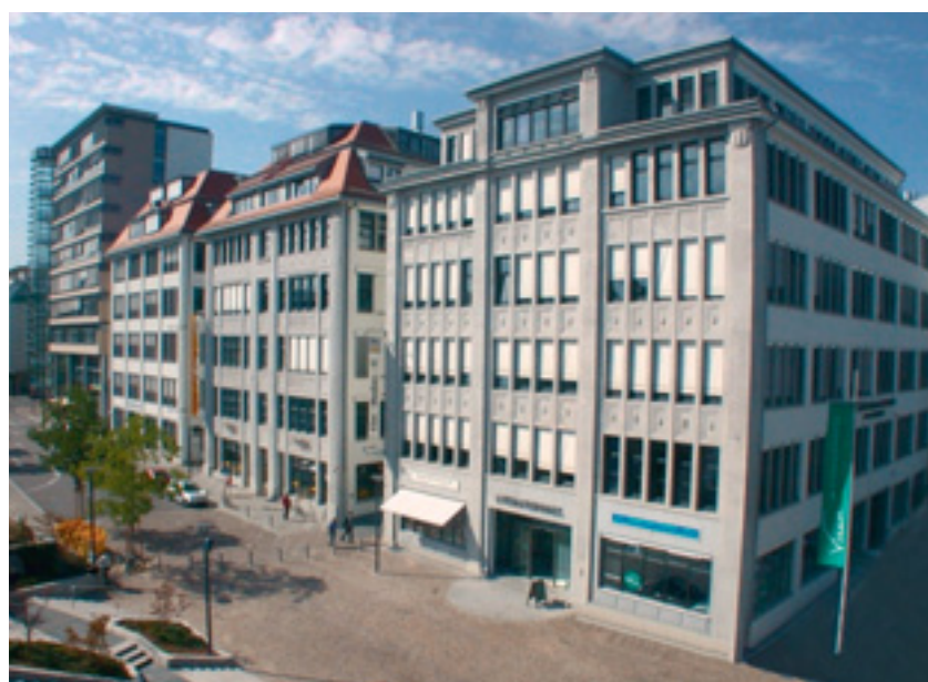
8 Sichtbetonfassaden im Bosch-Areal von 1911.
