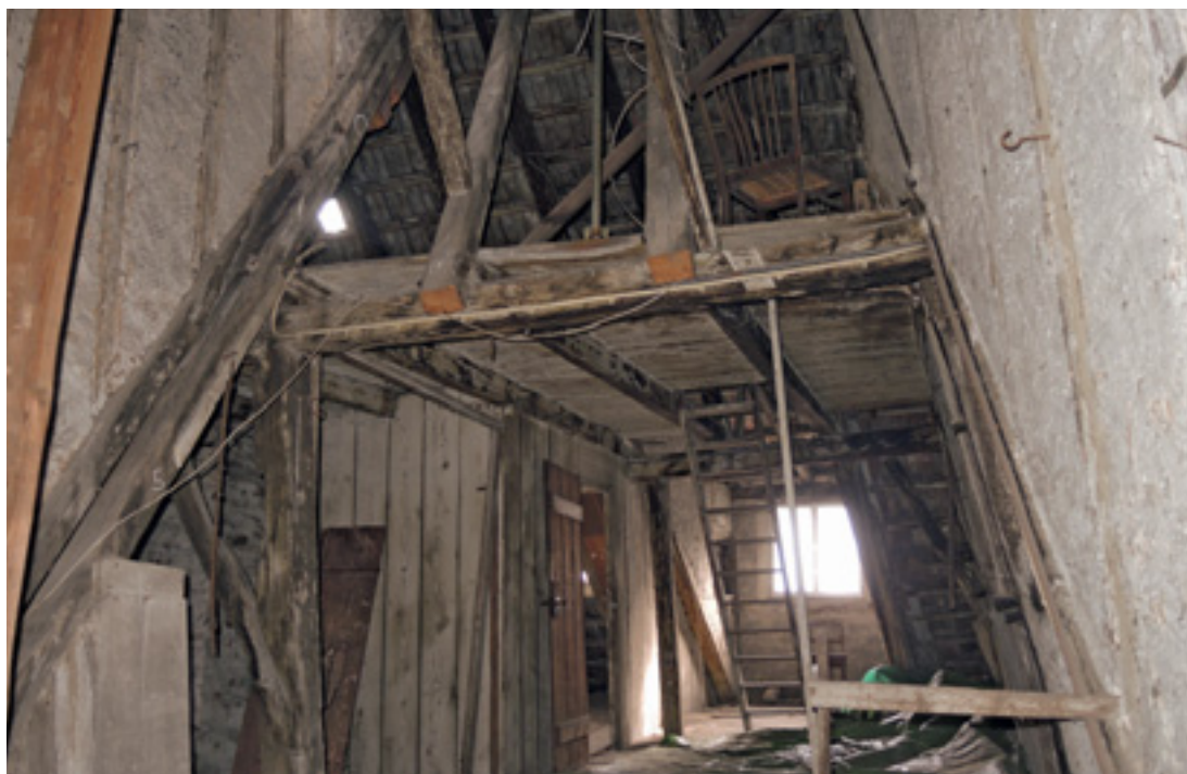
Blick auf das Dachtragwerk von 1487 im ersten Dachgeschoss von Gebäude Ehnisgasse 18.
