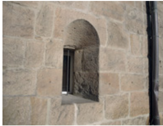
5 und 6 Rundbogiges Fenster mit Bogenquadern und leicht spitzbogig zulaufendes Fenster mit Sturzstein.
